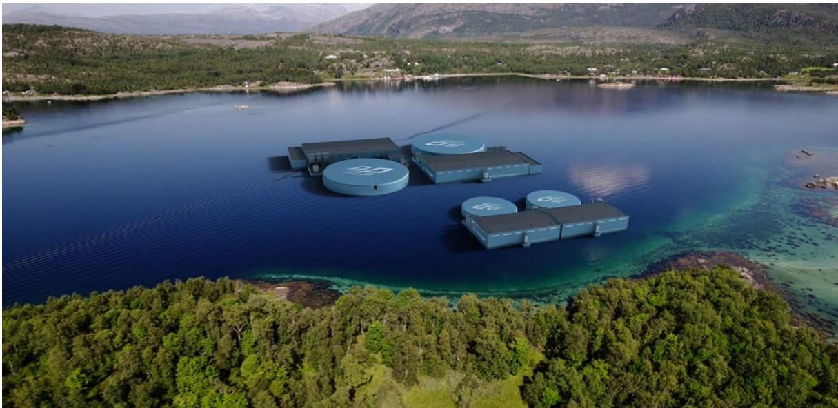
BILDE 5.1 MULTIGEN AKVA ANLEGG BESTÅENDE AV EN REKRUTTPLATTFORM – OG TO MATFISKPLATTFORMER.
