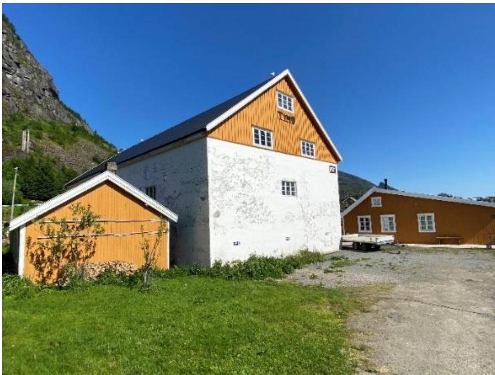
Storbrygga sett mot nord. Rorbu II til venstre.
