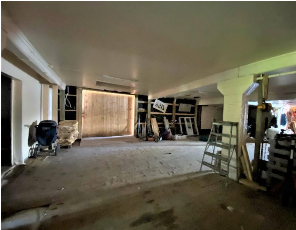
Fra første etasje med støpt dekke og kraftige støpte stolper og tredragere og store åpninger ut.
