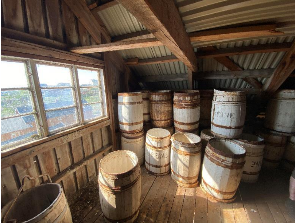
Fra øverste etasje på brua med tønnelager. Trematerialene er av sagd virke og de korrugerte stålplatene på taker er av ny dato.
