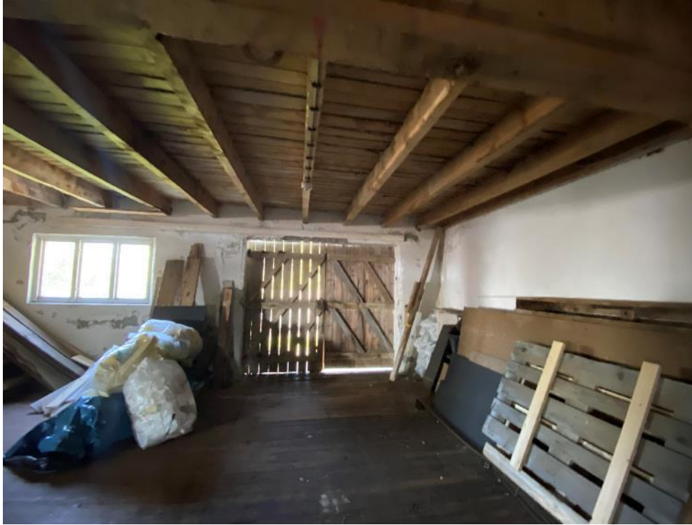
Fra andre etasje med trebjelkelag mellom etasjene og utgang mot terreng mot vest mot bru.
