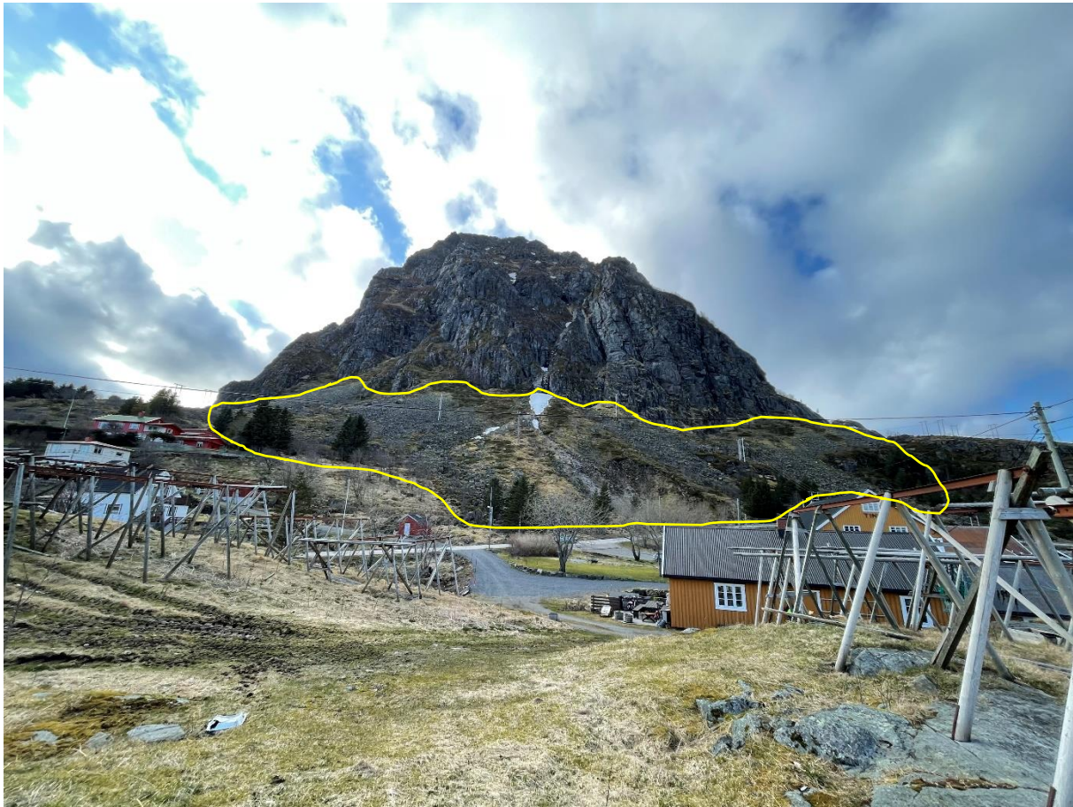
Figur 5: Bildet er tatt på befarings og viser at NGUs kartlegging av løsmasser stemmer med observasjoner på befarings, med fast fjell i øvre del av påvirkningsområdet og i kartleggingsområdet, samt skredavsetninger (gult polygon) i nedre del av fjellsiden.
