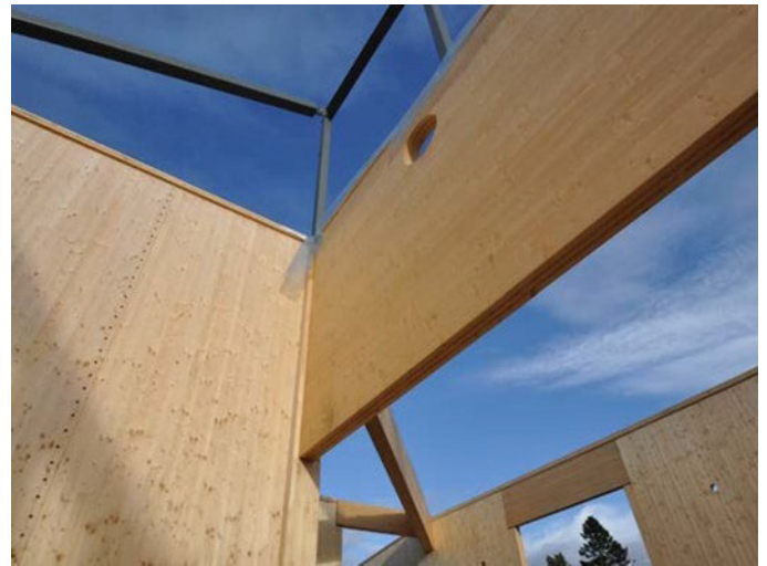
Stokmarknes ungdomsskole, under bygging i massivtre med løsning for fornybar energi.
